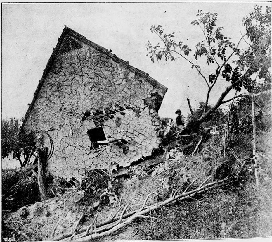
V chotáre obce Fényes následkom lejakov voda podmyla pôdu a dom šmikol sa dolu z vysokého breha.
