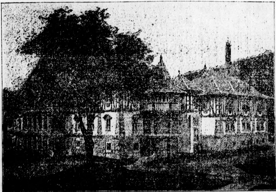
Jánov Dom. Prestavený dľa arch. Jurkoviča.
