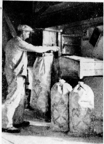
NYITOTT ZSÁKOK, amelyek úgy töltődnek, mint textilzsákok és zsínnyel, vagy egyszerű szerszám segítségével, dróttal zárhatók.
