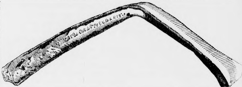
Abb. 3. Gelötetes Bleirohr aus den Kaiserschiffen im Nemisee (Thermen-Museum. Rom.)
