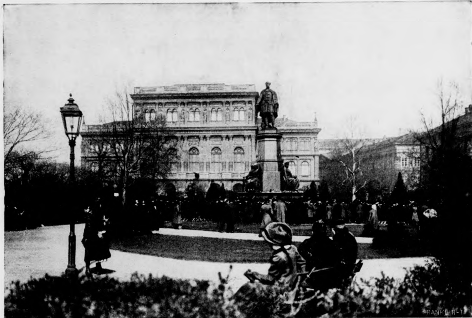
Pictures «Vasárnapi Ujság».
