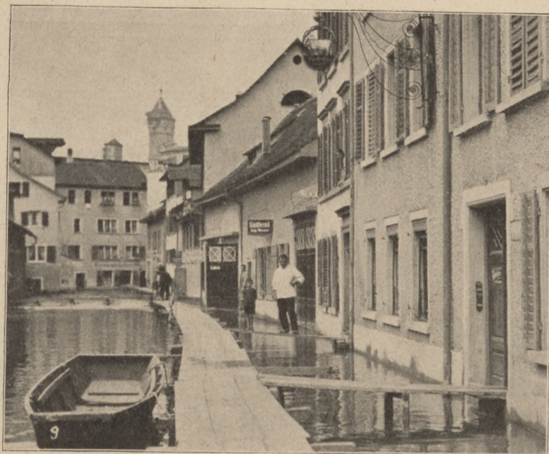
A schaffhauseni árvíz 1926-ban
