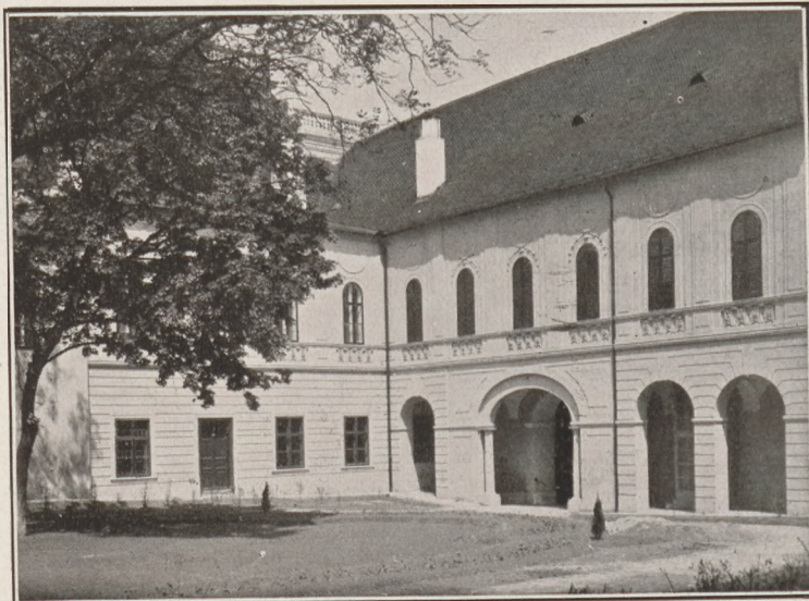
A régi levéltár épületének helyreállított udvari homlokzata
